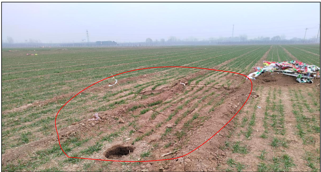
照片 5-13 新百泉村北岩溶塌陷坑（未完全塌陷）
